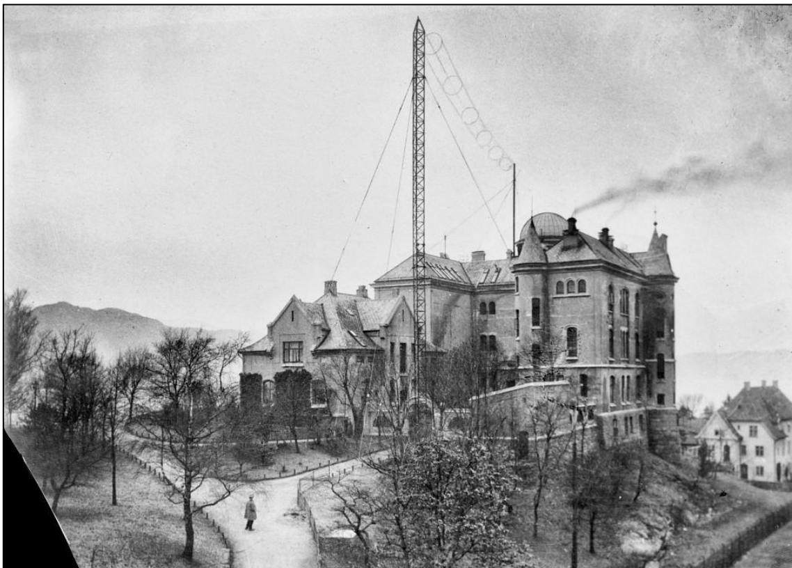
Bergens Kringkastingstasjon(1925). Senderen ble montert på Sjømannskolen på Nordnes i påvente av permanent lokalisering i det nye Telegrafbygget ved Byparken. Bilde: Atelier KK, Fotograf Knud Knutsen, ubb-kk-n-384-020 4 . 69+-
